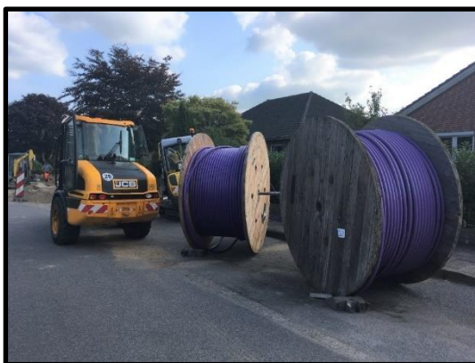
Glasfaserkabelrolle für die Haupttrasse
